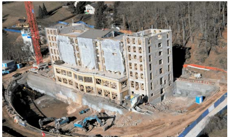
Vue d'ensemble pendant les travaux
